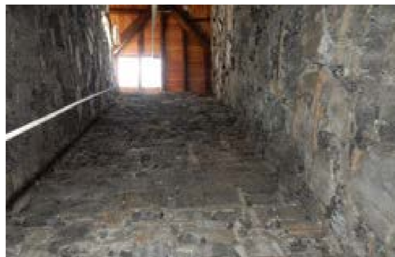
Foto 1: vista del cavedio con le due funi a cui era appeso l'operatore durante le fasi di montaggio dei piani di lavoro (al di sotto vi erano circa 10 m di vuoto)
