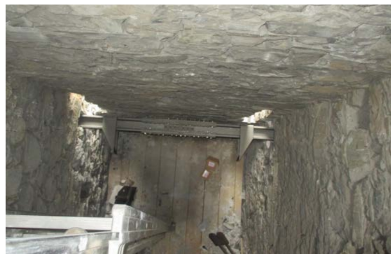
Foto 1: vista dall'alto del cavedio, in cui si nota il piano di lavoro e le putrelle, che fanno parte del sistema di ancoraggio delle catene
