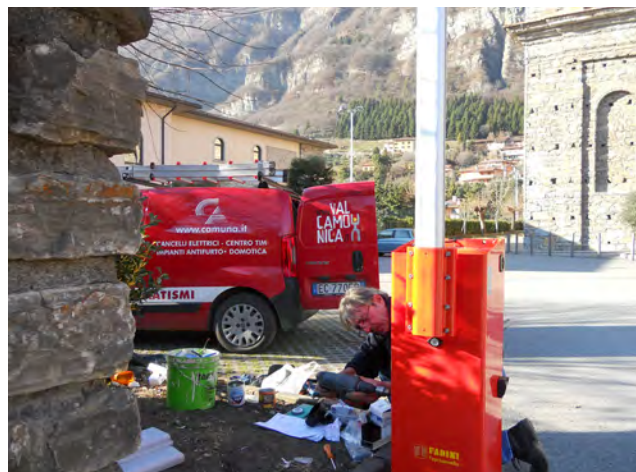
operatori della Camuna Automatismi durante il posizionamento della sbarra
